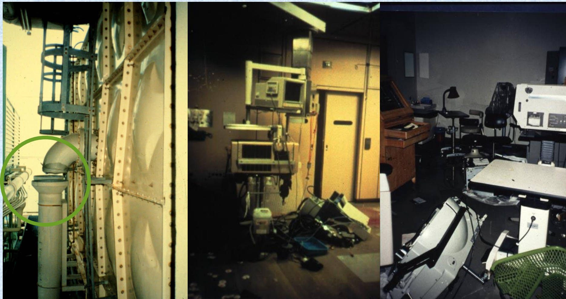
神戸市立中央市民病院 水配管・アンギオ装置・シンチグラムの破壊
